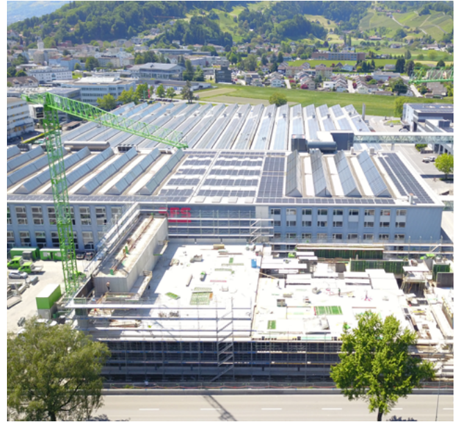
Anfang des Jahres startete der Bau der neuen Produktionshalle am Standort in Heerbrugg (Schweiz) zur Realisierung von Projekten im Bereich elektrischer Bremssysteme.
