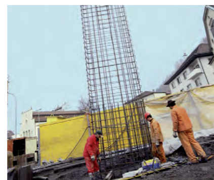
Versetzen des Schlitzwand-Bewehrungskorbes
